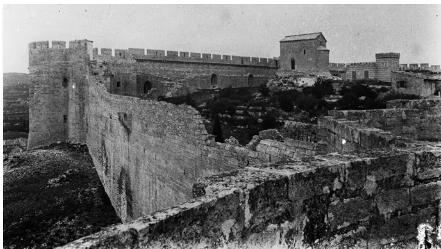
Le crénelage en cours de restauration, 1909 © Jules Tillet / Médiathèque de l'architecture et du patrimoine
